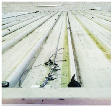
Linea vita che deve essere predisposta su ogni blocco prefabbricato per consentire le operazioni prevenendo il rischio di caduta dai bordi
