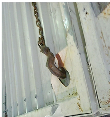
Il lavoratore sale sul container e si assicura a linea vita esistente per sganciare i ganci di sollevamento. Sempre assistenza alla base della scala per evitare che scivoli o sbandieri.
